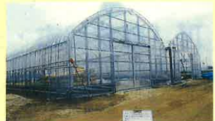
補助事業を活用して導入したハウス
